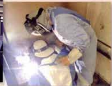
電気溶接職種
